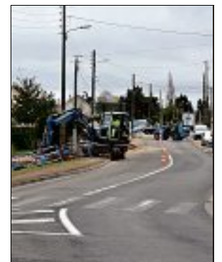
Les travaux sur la RD93.
