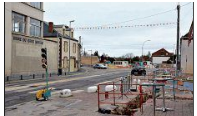
La circulation alternée est en place sur cette portion.
